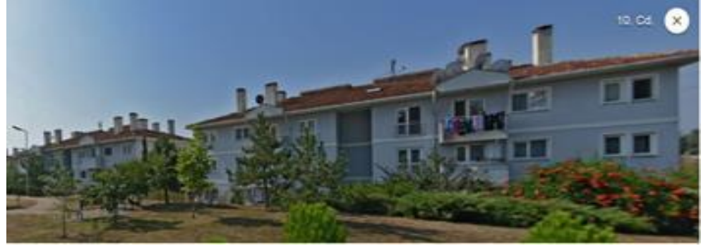
Trifaze Pilot Bölgesi (GPRS & RF'li Modem İle Okuma)
